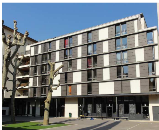
... et après les travaux de reconstruction de 2005
