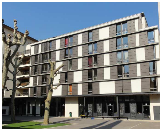
... et après les travaux de reconstruction de 2005
